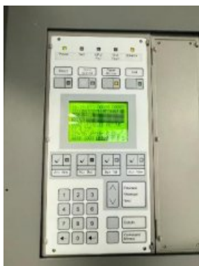
รูปที่ 49 ระบบควบคุมแจ้งเตือนเพลิงไหม้ (Fire Alarm control Panel:FACD)
