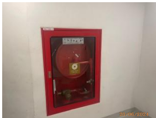
รูปที่ 42 ตู้เก็บสายฉีดน้ำดับเพลิง และป้ายแนะนำการใช้อุปกรณ์
