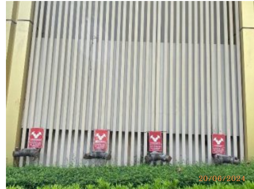
รูปที่ 41 หัวรับน้ำดับเพลิงภายนอกอาคาร
