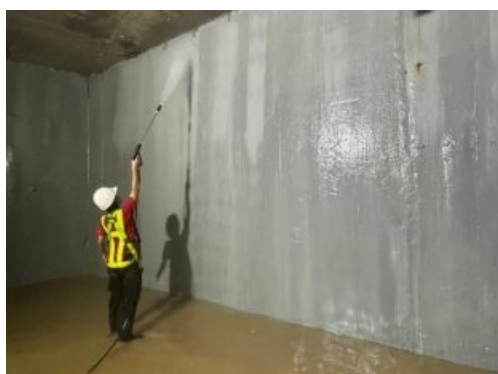
รูปที่ 26 การล้างถังสำรองน้ำใช้ของโครงการ
