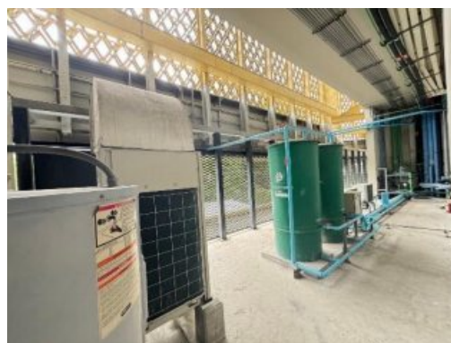
รูปที่ 19 ระบบกำจัดก๊าซมีเทน
