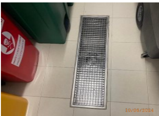
รูปที่ 33 ท่อรวบรวมน้ำเสียในห้องพักมูลฝอย
