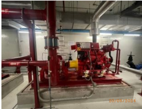
รูปที่ 45 เครื่องสูบน้ำดับเพลิง
