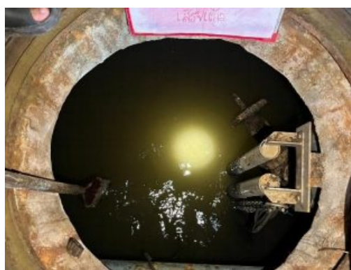
รูปที่ 21 การตักไขมันในถังดักไขมันของโครงการ
