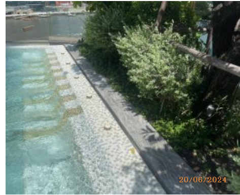
รูปที่ 73 รางระบายน้ำล้นของสระว่ายน้ำ
