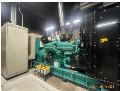
รูปที่ 56 เครื่องกำเนิดไฟฟ้าสำรองของโครงการ
