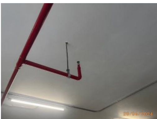
รูปที่ 43 ระบบหัวกระจายน้ำดับเพลิง
