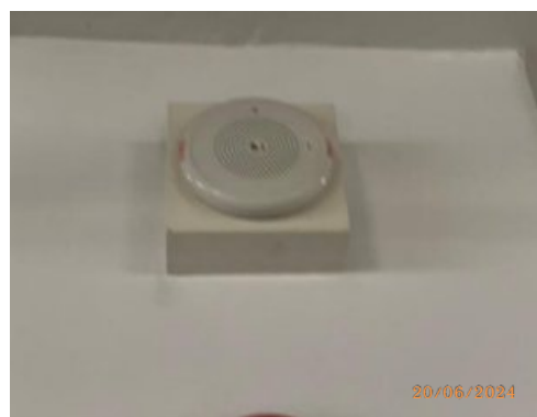
รูปที่ 53 อุปกรณ์ส่งสัญญาณแจ้งเหตุอัคคีภัย
