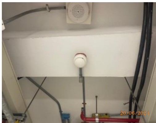
รูปที่ 51 เครื่องจับความร้อน (Heat Detector)
