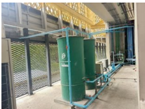
รูปที่ 18 ระบบบำบัดสำเร็จรูป (Filter Scrubber)
