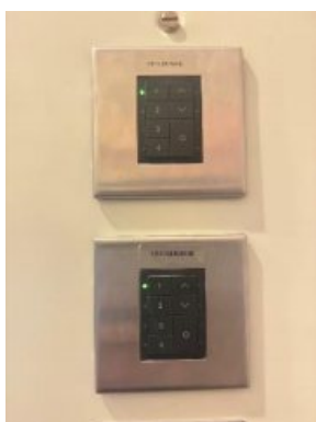
รูปที่ 97 เครื่องปรับระดับแสงสว่าง (Dimmer)
