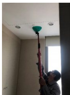
รูปที่ 98 ตรวจสอบระบบป้องกันและเตือนอัคคีภัย
